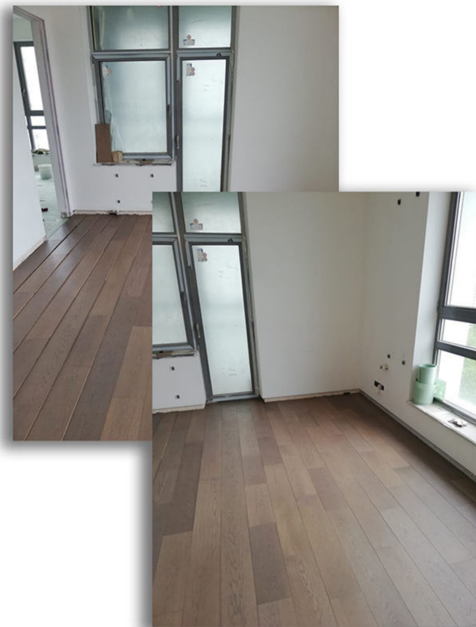
5. Укладка напольного покрытия.
