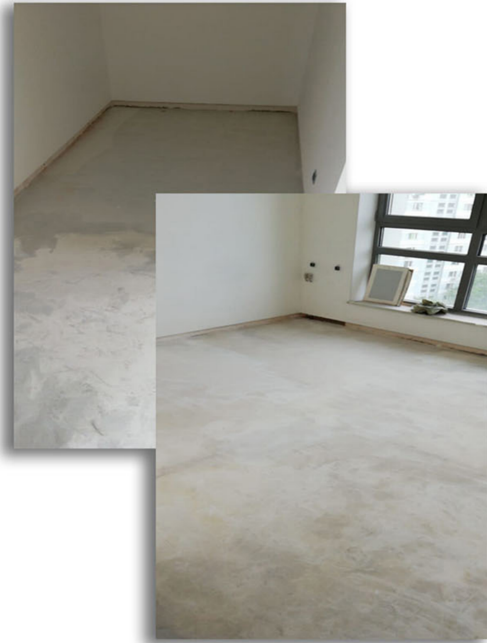
1. Выравнивание стяжки специальным составом и подготовка пола к грунтовке.
