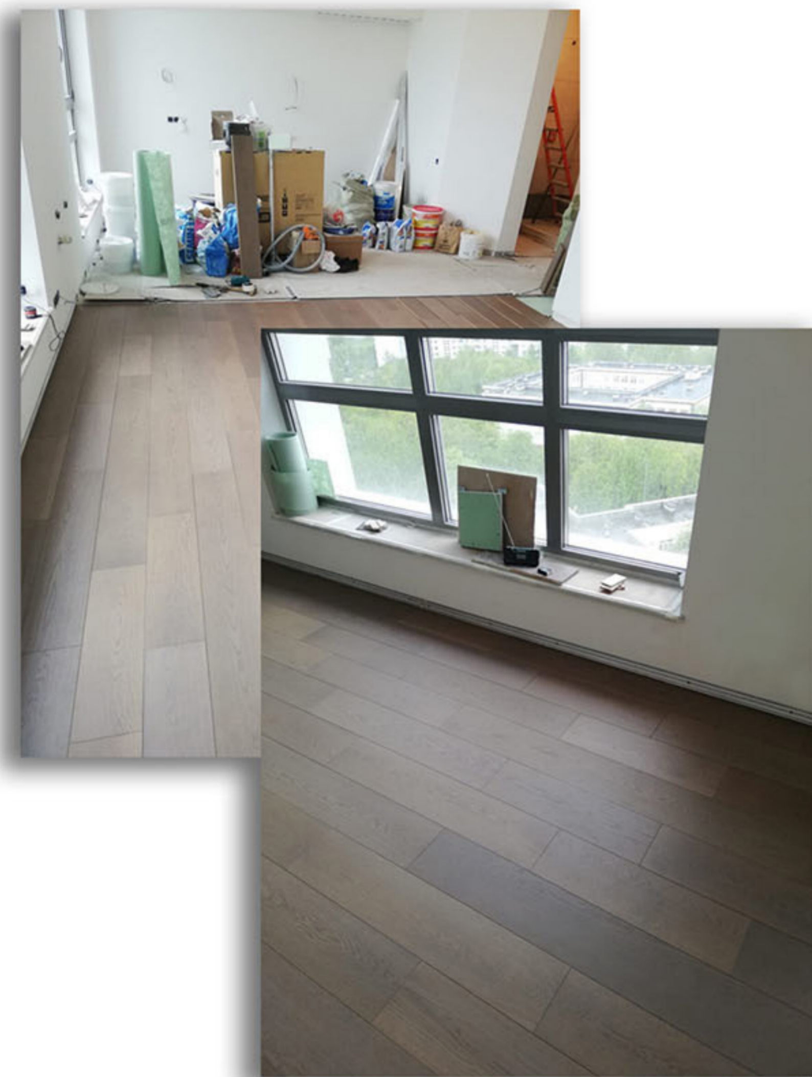
6. Уложенный паркет (инженерная доска покрытая маслом).
