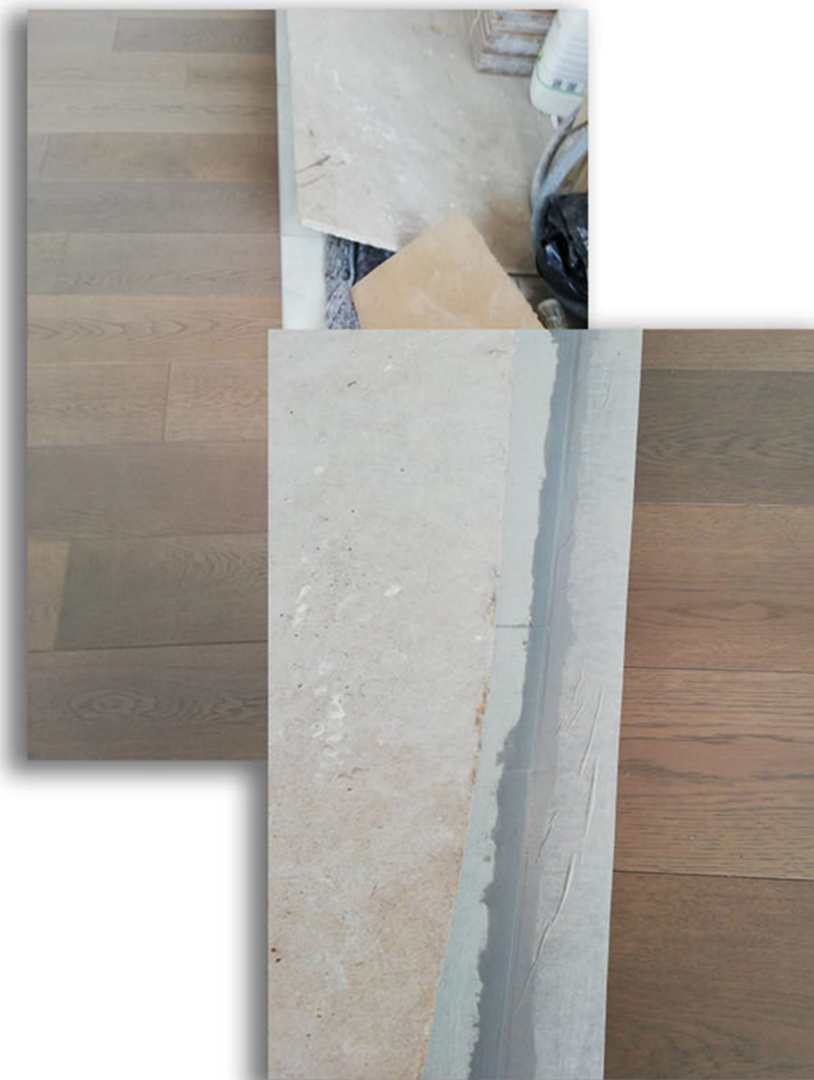
7. Герметизация шва ограниченного примыкания неопреновым герметиком
