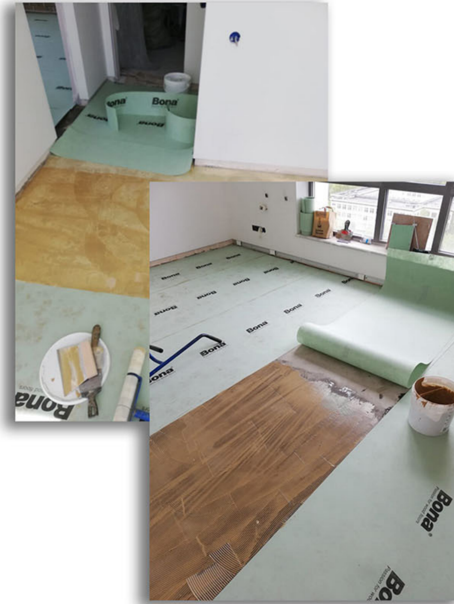
3. Установка разделительной подложки на двухкомпонентный клей.
