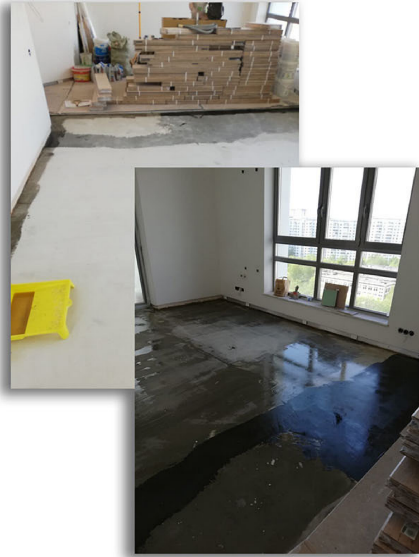
2. Грунтовка стяжки в два этапа – по периметру и всему помещению.
